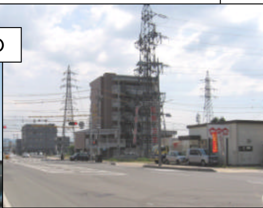
整備前(平成18年8月)
