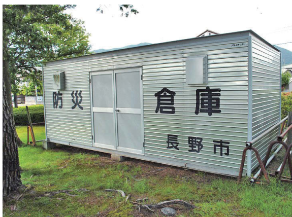
防災備蓄倉庫（昭和の森公園）
