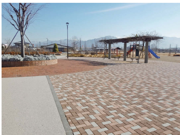
駐車場から公園を周遊できるバリアフリー法に基づき整備された移動等円滑化園路（篠ノ井中央公園）
