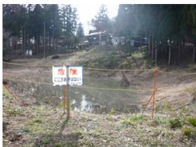
立入防止柵と注意喚起看板
