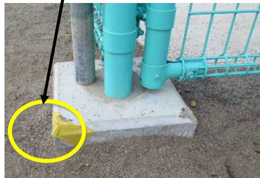
【コンクリート基礎ブロックの状況】
