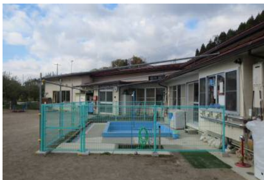
【フェンス設置工 全景】
