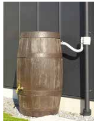
▲雨水貯留タンク 設置例
