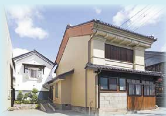
うちくら 内蔵と住居の併用住宅 (大字長野桜枝町)
