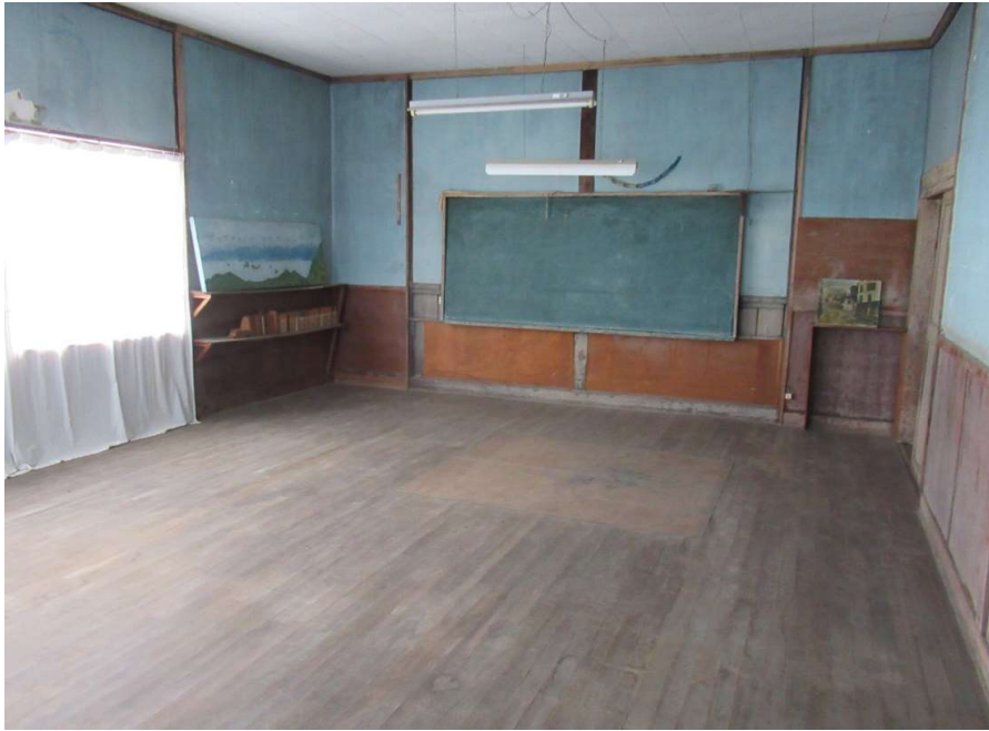
2階建物内(図書室)
