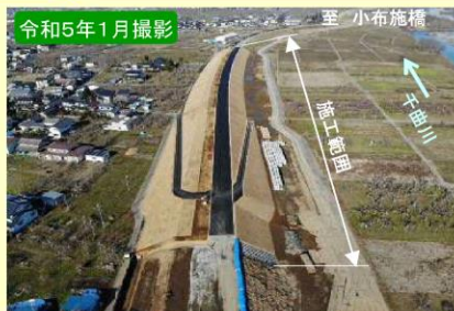
現地施工状況②
