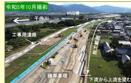
現地施工状況②
