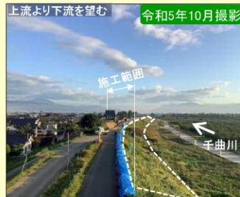
現地施工状況②
