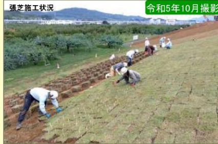
現地施工状況②
