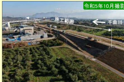
現地施工状況①
