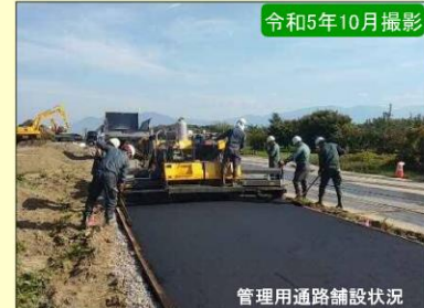
現地施工状況②
