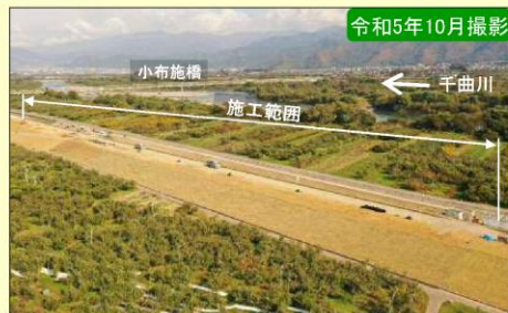
現地施工状況②
