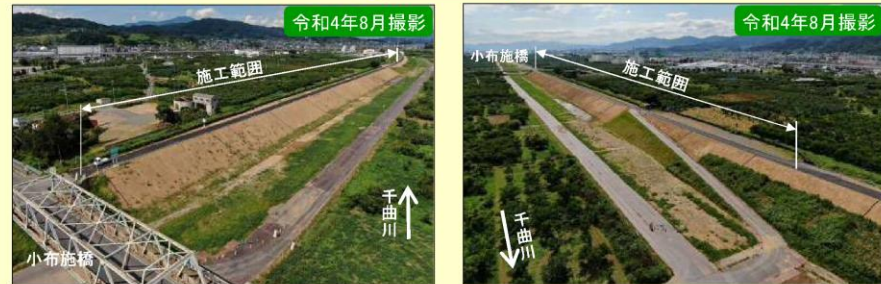
現地施工状況①
