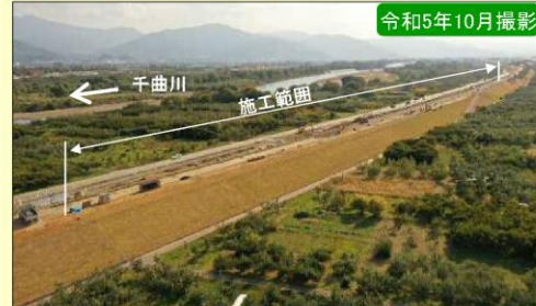
現地施工状況①
