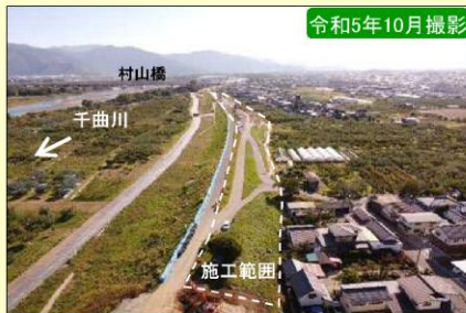
現地施工状況②
