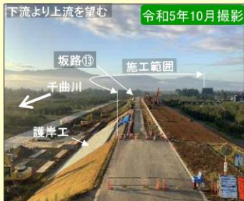
現地施工状況①
