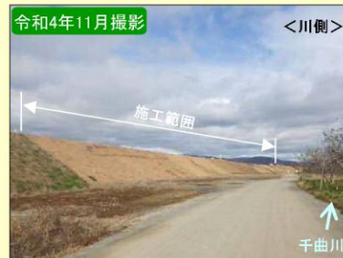
現地施工状況①
