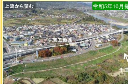
現地施工状況①
