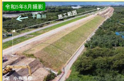
現地施工状況①
