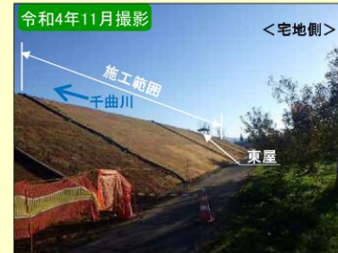
現地施工状況②
