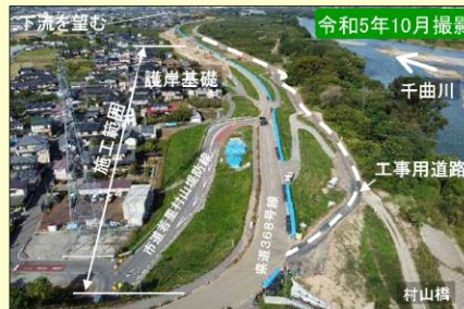
現地施工状況①
