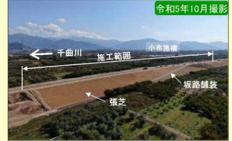
現地施工状況②
