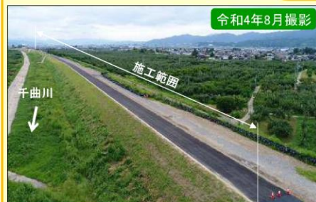
現地施工状況①
