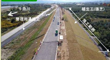
現地施工状況①
