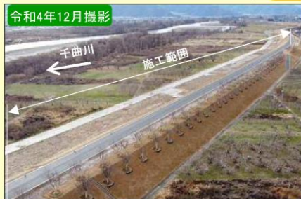
現地施工状況①
