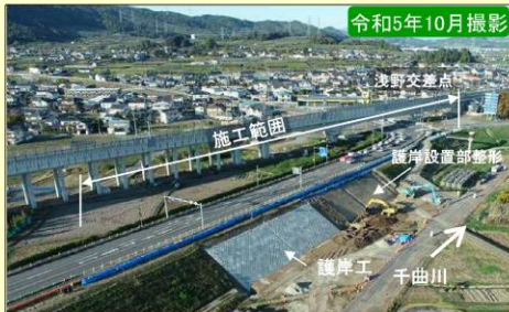
現地施工状況①
