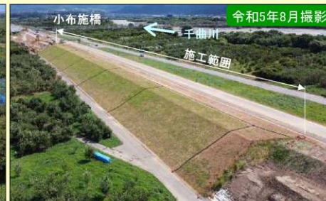
現地施工状況②
