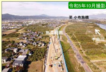
現地施工状況①
