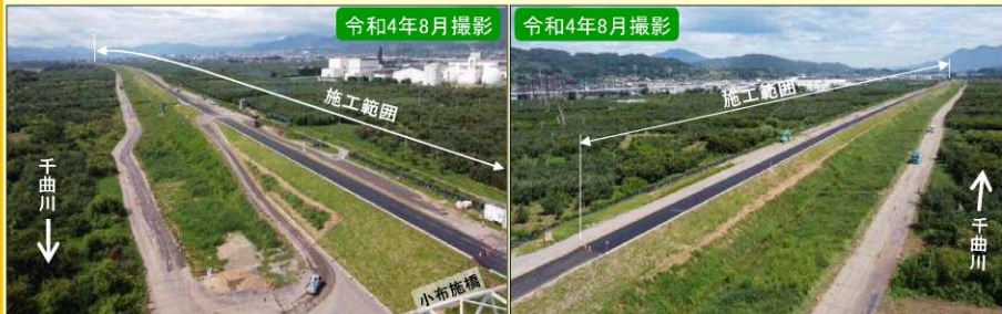
現地施工状況①
