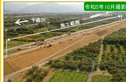
現地施工状況①
