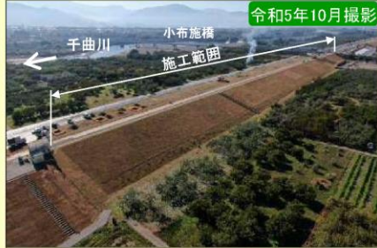
現地施工状況①
