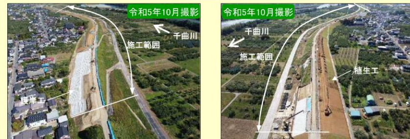
現地施工状況①
