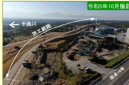
現地施工状況②
