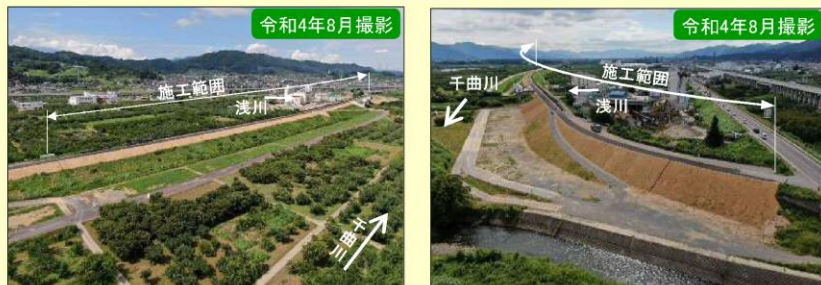
現地施工状況①
