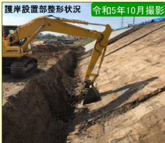
現地施工状況②
