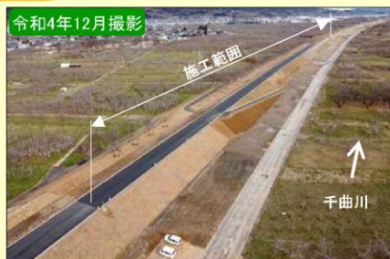
現地施工状況②
