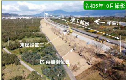
現地施工状況②
