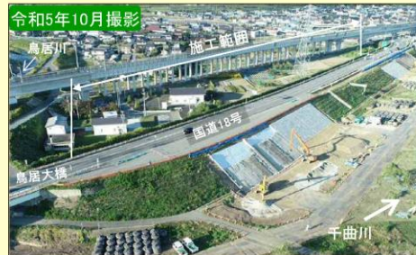
現地施工状況
