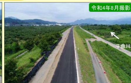
現地施工状況②
