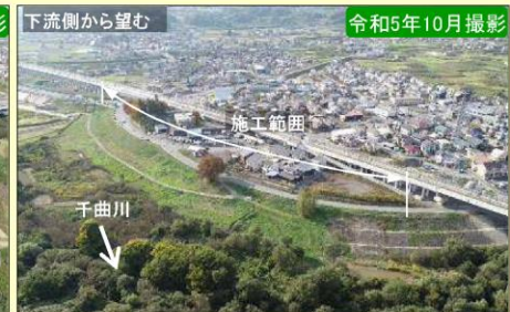
現地施工状況②
