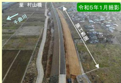
現地施工状況①
