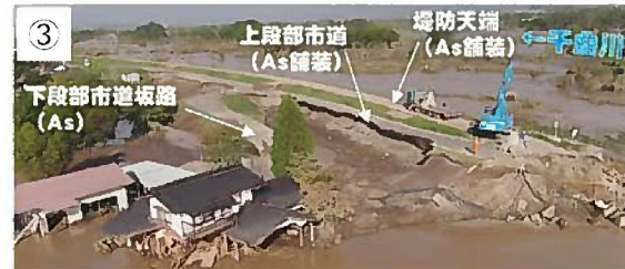
③決壊部下流側(令和元年10月13日撮影)
