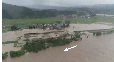
新潟県小千谷市内における 浸水被害状況
