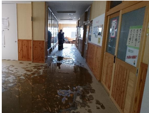
<被災直後の南校舎廊下>
