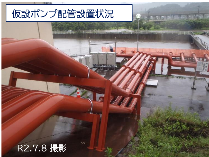
<浅川第二排水機場>
