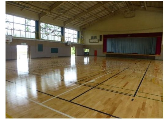
<復旧後の体育館>
