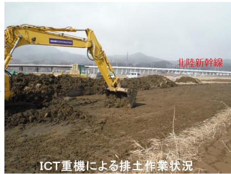
<復旧作業の状況>
