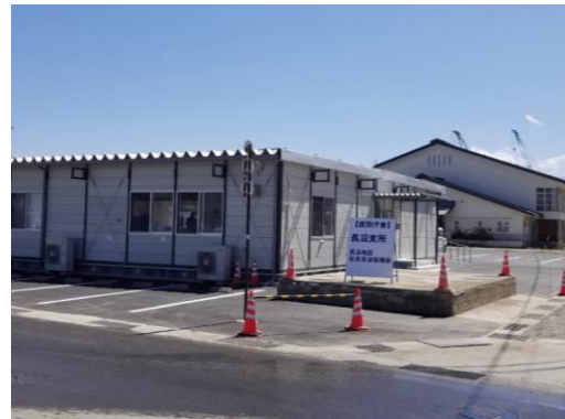
<仮設庁舎外観>
