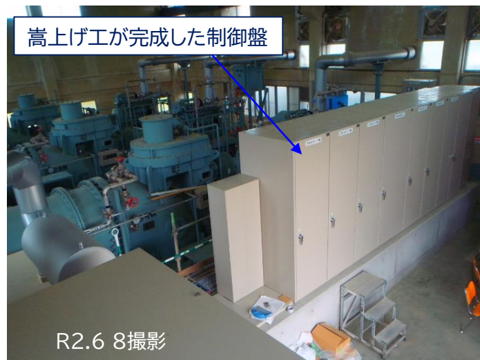
<小森第一排水機場>
