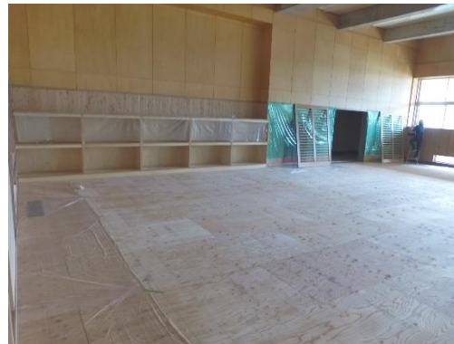
<復旧中の武道場>
