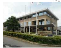
豊野支所内事務室設置
