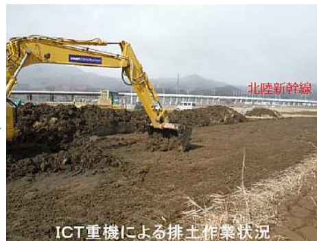
ICT重機による排土作業状況 <復旧作業の状況>
