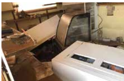
浸水し、什器や機械類が散乱(10月14日撮影)
