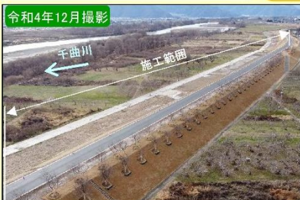
現地施工状況①
