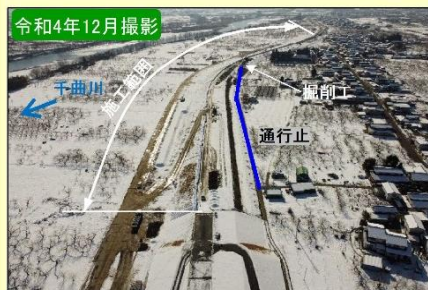
現地施工状況①
