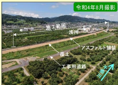
現地施工状況①
