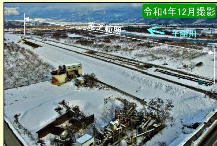
現地施工状況①
