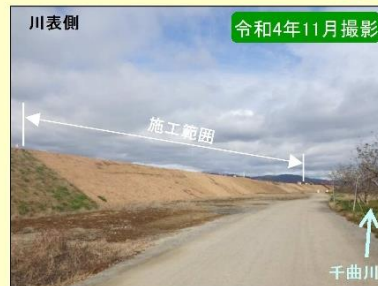
現地施工状況①
