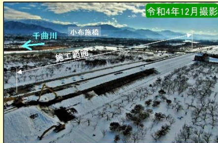
現地施工状況②
