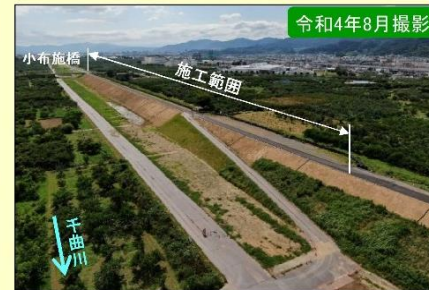
現地施工状況②
