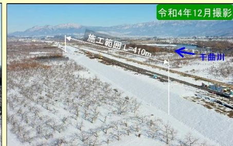
現地施工状況②
