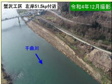
現地施工状況①
