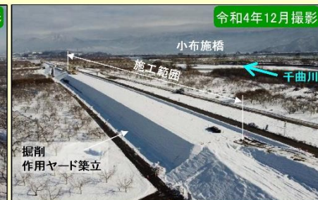
現地施工状況②
