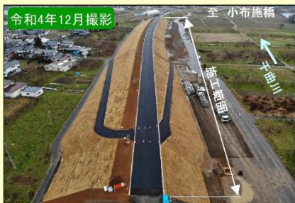
現地施工状況②
