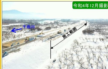
現地施工状況①
