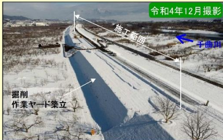
現地施工状況②
