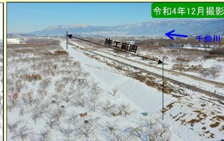
現地施工状況②
