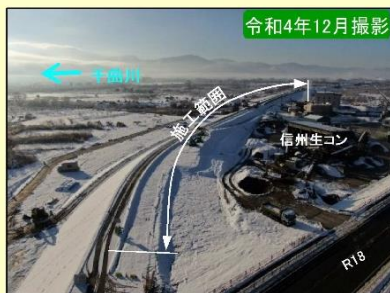
現地施工状況②
