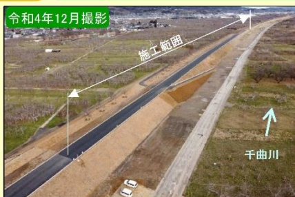
現地施工状況②
