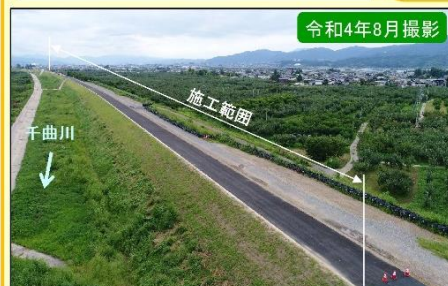
現地施工状況①
