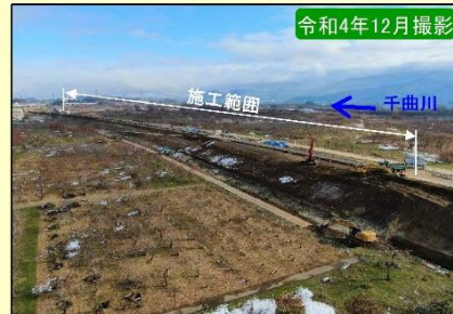
現地施工状況①
