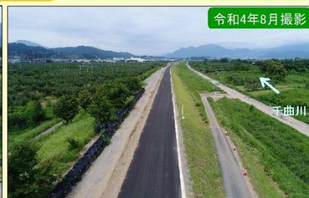
現地施工状況②
