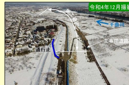
現地施工状況②
