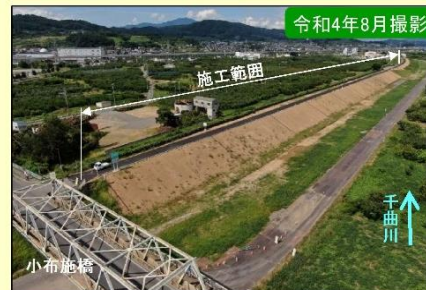
現地施工状況①
