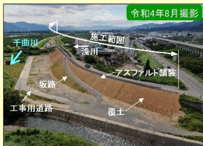
現地施工状況②
