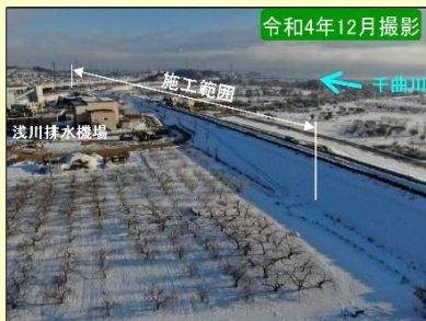
現地施工状況①
