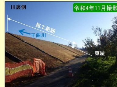
現地施工状況②
