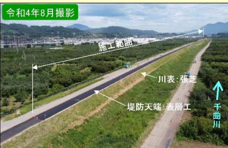
現地施工状況②
