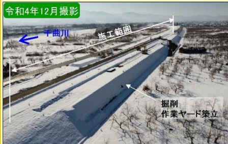
現地施工状況①
