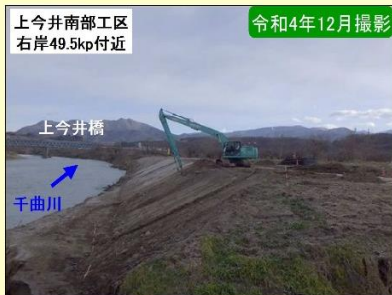
現地施工状況②
