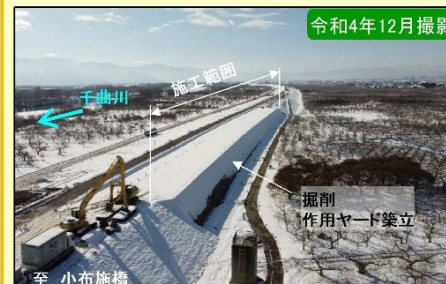
現地施工状況①
