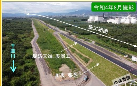
現地施工状況①
