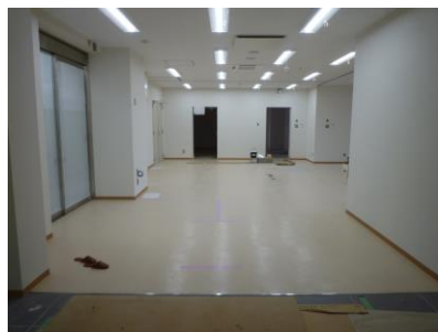
執務室施工状況
