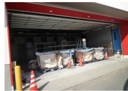
車庫施工状況
