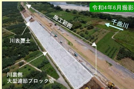
現地施工状況②
