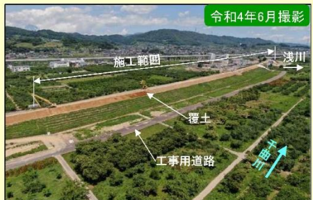
現地施工状況①
