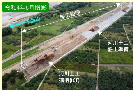
現地施工状況①
