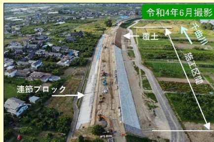
現地施工状況②
