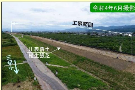
現地施工状況①
