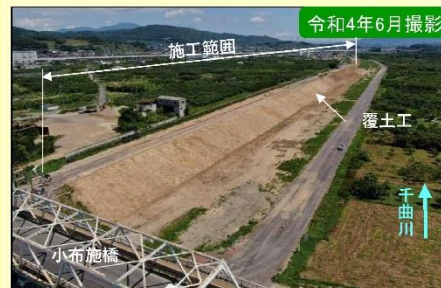
現地施工状況①
