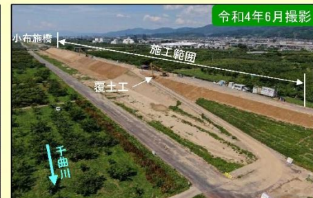
現地施工状況②
