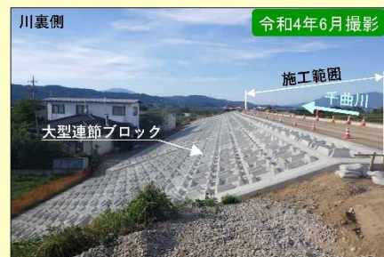
現地施工状況②
