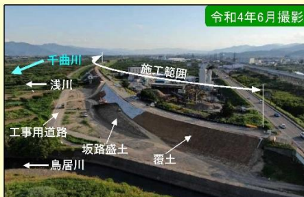
現地施工状況②
