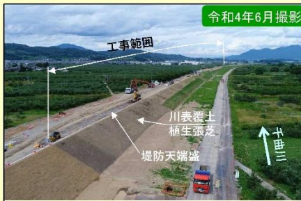
現地施工状況②
