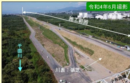
現地施工状況①
