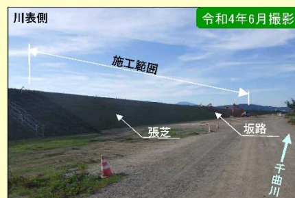
現地施工状況①
