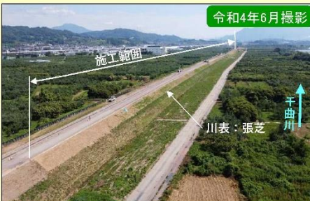
現地施工状況②
