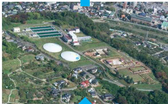
夏目ヶ原浄水場
