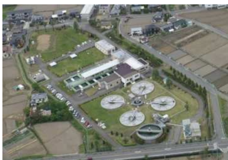
諏訪形浄水場
