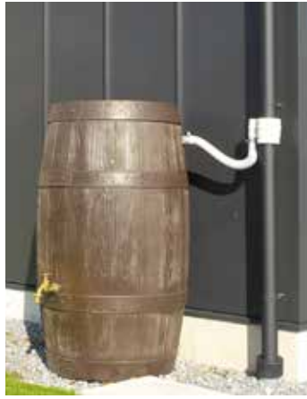
▲雨水貯留施設の設置例
